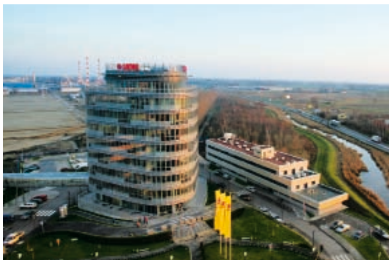
Charakterystyczna siedziba Grupy LOTOS S.A. oraz teren inwestycji Programu 10+ stały się wizytówką rozwoju gdańskiej aglomeracji.
